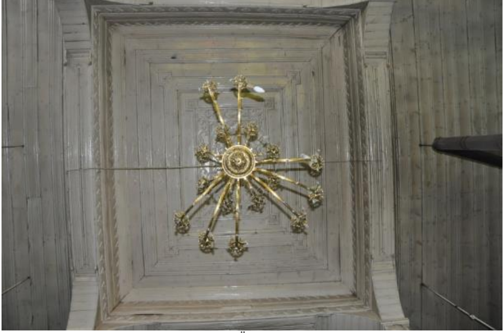
Foto. 5: Ahşap Örtüden Bir Görünüş
