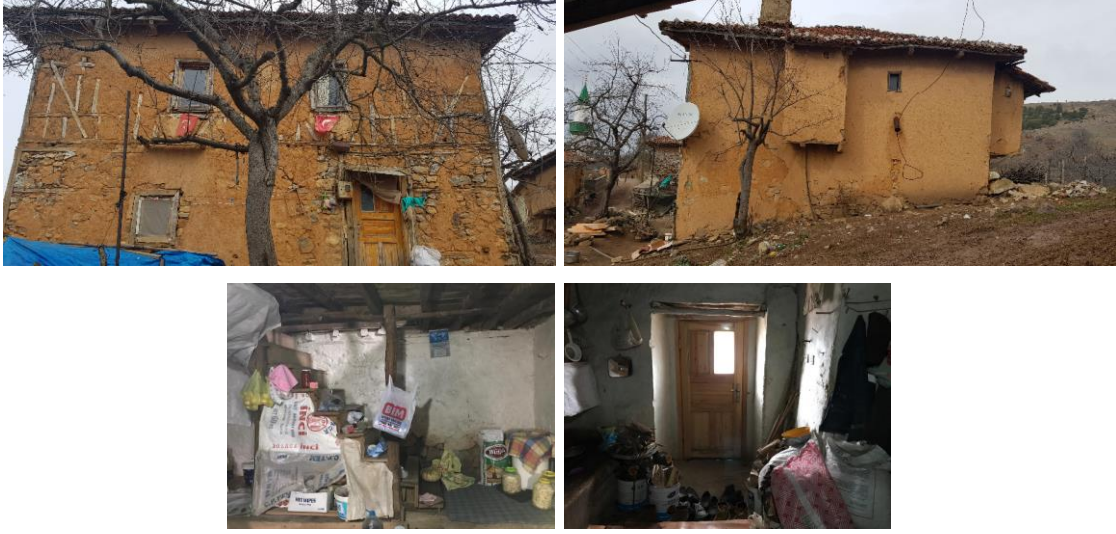
Şekil 10. Mehmet Babuç evi güneybatı, güneydoğu cephesi ve iç mekan (Yazarın arşivi,2019)
