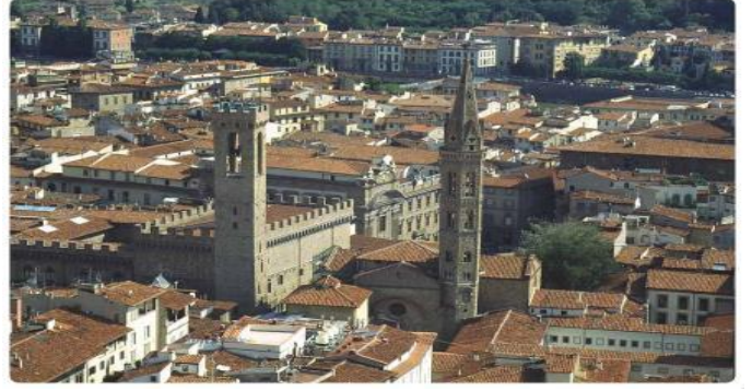
Resim 14. Badia Fiorentina Kilisesi, Floransa cephe detayı
