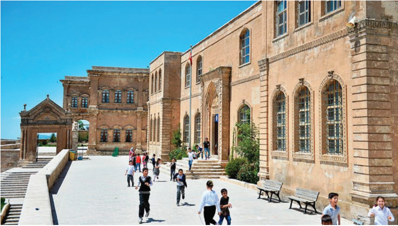
Görsel 7: Günümüzde Gazipaşa İlkokulu olarak kullanılan idadi mektebi ek binası güney cephesi ve süslemeli taş işçiliği (Sincar, 2019)
