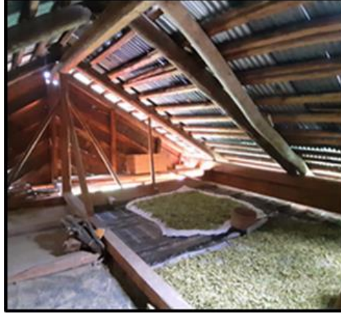
Fotoğraf 37: Çatı katından görünüm.
