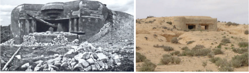
Şekil 8: Solda; Atlantik Duvarı'na ait betonarme korugan (Zaloga, 2007); sağda; Maret Savunma Hattı'na ait betonarme korugan (Ford, 2012).
