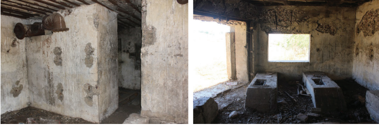
Şekil 38: Büyükçekmece ilçesi 385 ada, 4 parseldeki korugan. (M. Efeoğlu, 2020)
