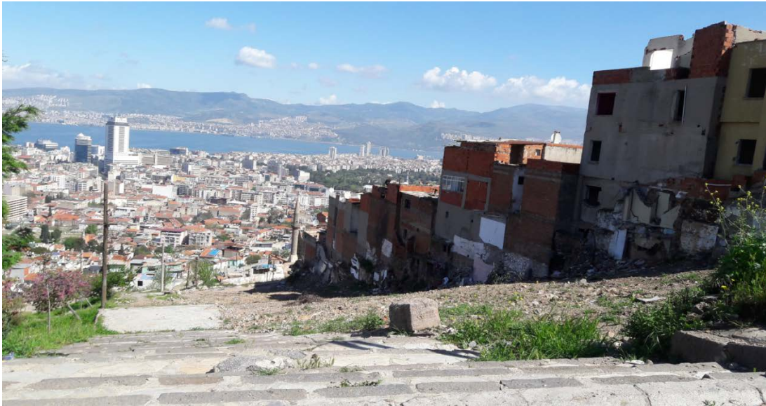
Fotoğraf 5. Kadifekale 'de yıkım yapılmış bir alan
