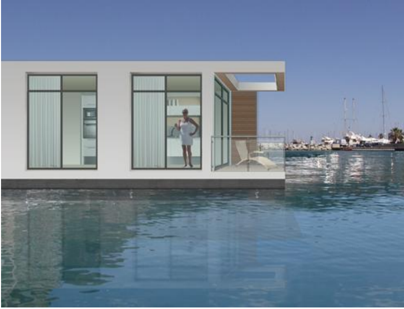
Şekil 15 Yüzen evlerin alt yapı ve diğer kamusal bağlantıları atık yönetimi elektrik tesisatı ve diğer sabit bit yapıda bulunması gereken araçlarla ve bağlantı sistemleri ile aynı özellikleri taşımaktadır ( http://ifitshipitshere.blogspot.com/2007/09/floating-houses-wave-of-future.html#sthash.BzgBNlzS.dpuf ).
