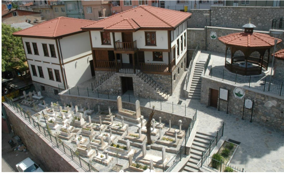
Seyyid Usûl Dergâhı ve hazîresi restorasyondan sonra. KARAR-I ŞEMSÎ 'ye göre , (s. 46) Seyyid Usûl Dergâhındaki mezarlar:
