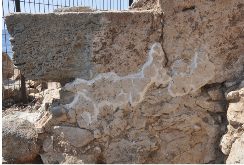
Resim 20 - LA-1 Güneybatı Duvardaki Sıva. Restorasyondan Sonra (İhtiyar, 2016: 100, Levha 19/A)
