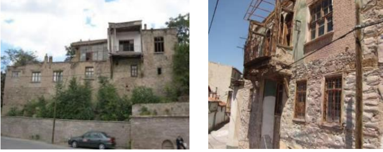
Şekil 3. Durmuş Ali Okal Evi (solda) Ahmet Oymak Evi (sağda) (Kuyrukçu ve Yıldız Kuyrukçu, 2015)
