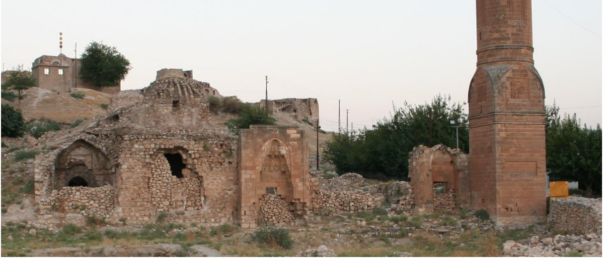
Resim 17: Şehabiye Medresesi'nin Doğu Cephesi.
