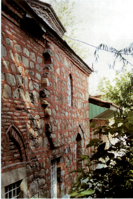
Resim 7 - Güneyde türbe ile cami beden duvarı birleşme detayı
