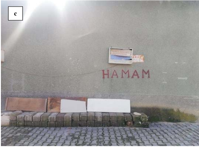
Fotoğraf 3. Yazıköy Hamamı yıkık olduğu için kullanılmamaktadır
