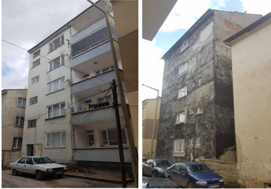
Şekil 1. Ön ve Arka cephe Görünümü
