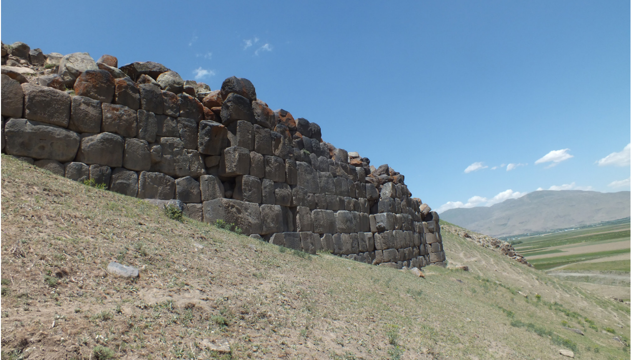
Resim 5: Körzüt Kalesi'nin sur duvarı görünümü
