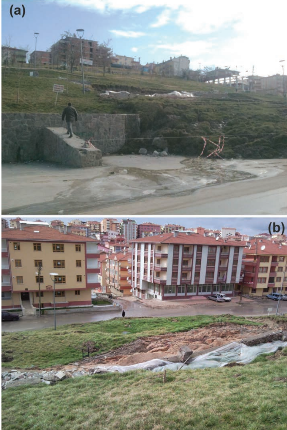
Şekil 3. Parkın kuzey-batı kesiminde meydana gelen heyelandan bazı görünümler, a. Heyelanın topuk kısmından bir görünüm, b. Heyelanın tepe kısmından bir görünüm.
