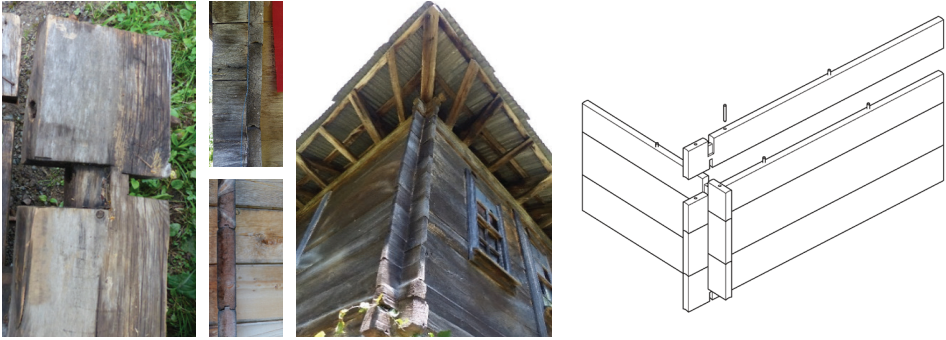
Resim 5. Duvar kalas elemanlarının köşe birleşimleri
