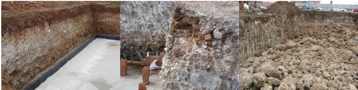
Şekil 8. Konglomera temel kazılarında gözlenen yüzey koşulları ve tanesal dağılım özelliklerinin genel görünümü (Typical surface conditions of the conglomerate unit observed in foundation excavations, and general view of the granular distributions)
