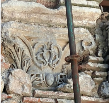
Fot. 4: Harim kuzey cephe
