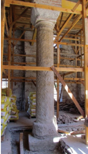
Fot. 23: Sütun altına yerleřtirilmiř andezit kesmetař blok
