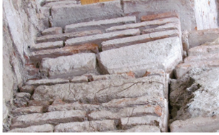
Fot. 20: Eserin kuzey cepheye bakan yüzü
