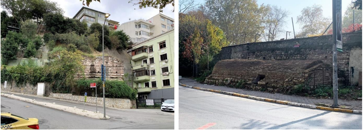
Şekil 14. Solda Üsküdar'da bulunan bir sarnıç, sağda Tersane-İstanbul Projesi kapsamında yapılan çalışmalarda Kasımpaşa Kulaksız'da ortaya çıkarılan sarnıç.
