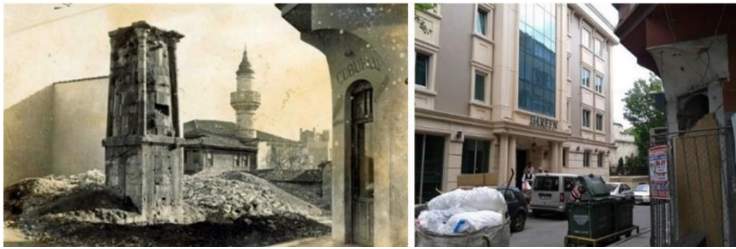
Şekil 13. Solda Fatih Kızıtaşı Caddesi üzerinde bulunan Saraçlar su terazisinin geçmişteki görünümü (100 yıl, 2014), sağda su terazisinin yıkılması sonrasında yerine yapılan binanın günümüzdeki hali (100 yıl, 2014).
