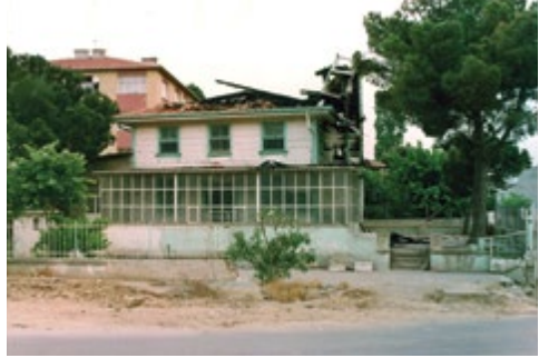
Fotoğraf 10: Namazgâh Camii, 1994 yılı yangın sonrası görüntüsü. Camekânla kapatılarak son cemaat yerine dönüştürülmüş olan kuzey cephe ve minare ile çatının yangın sonrası durumu, Vakıflar Genel Müdürlüğü İstanbul 2. Bölge Müdürlüğü Arşivi.
