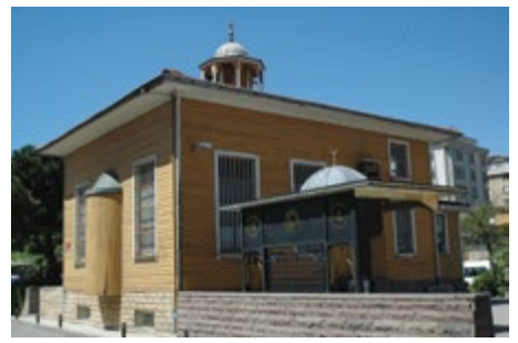
Fotoğraf 14: Namazgâh Camii, mihrabın olduğu Sütçü Sokağı yönünden görünüşü, 2012. Caminin mihrab ve doğu cephesi ile avludaki yeni musalla taşı ve üst örtüsü.
