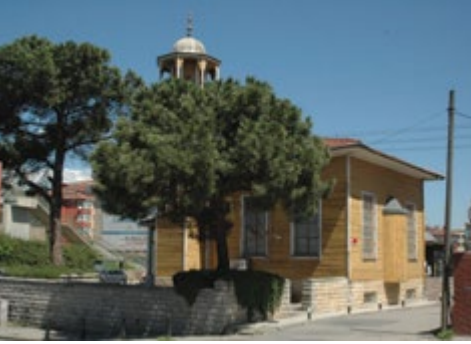
Fotoğraf 18: Namazgâh Camii, İzzettin Bey Sokağı ve mihrabın olduğu Sütçü Sokağı yönünden görünüş, 2012.
