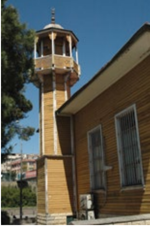
Fotoğraf 16: Namazgâh Camii, batı cephesinden harim pencereleri ve minareden genel görünüm, 2013.
