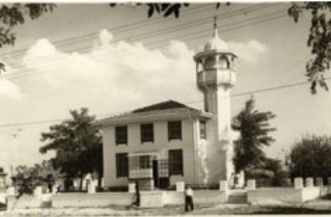
Fotoğraf 7: Namazgâh Camii genel görünüş. Avlu duvarı önünde tulumba ile üç musluklu abdest alma bölümü vardır. İbrahim Hakkı Konyalı Kütüphanesi Arşivi No:5342/104.
