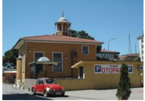
Fotoğraf 19: Namazgâh Camii, mihrabın olduğu Sütçü Sokağı yönünden görünüş, 2012. Caminin doğu cephesi ve avludaki musalla taşı üst örtüsü ve abdest alma mahalli ile bodrum kattan avluya açılan kapı.
