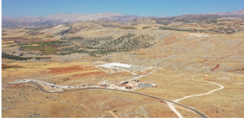
Şekil 6 Adıyaman Katı Atık Tesisinin Kuşbakışı Görüntüsü
