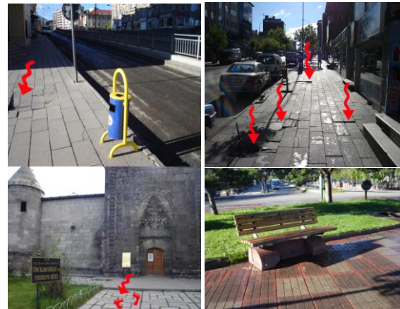
Şekil 1. Çalışma alanı içerisindeki olumlu ve olumsuz döşeme örnekleri.
