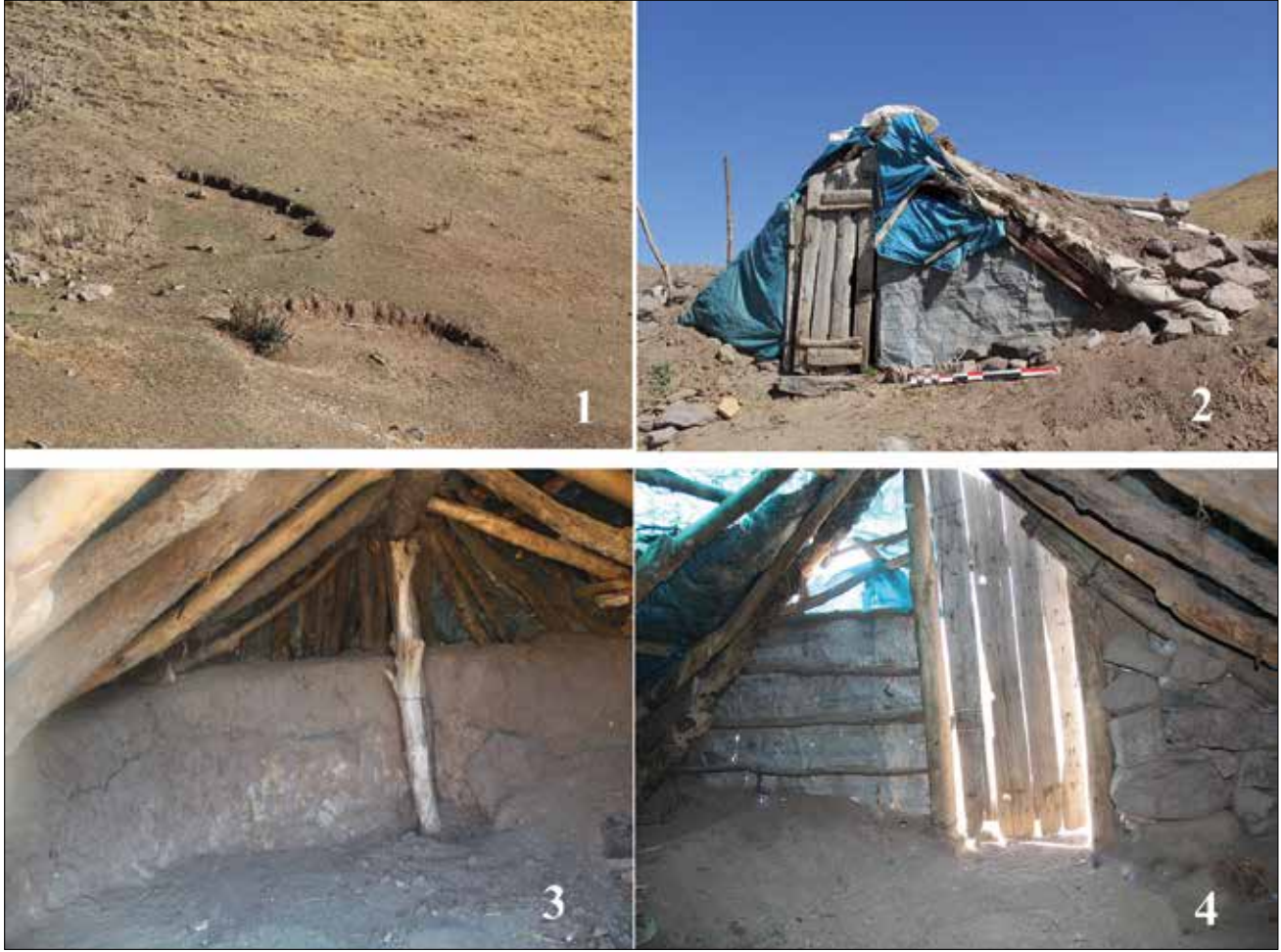
Fotoğraf 10: Nahçıvan yaylalarındaki çukur tabanlı barınak örnekleri / The semi-subterranean building from plateau of Nakhchivan (Veli Bahşeliyev)
