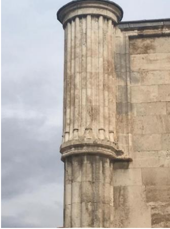
Resim 16. Dilimli Payanda Gövdesi Resim 17. Dilimli Gövdeli Taç Kapı Köşe Sütunceleri
