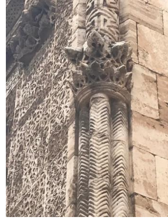
Resim 16. Dilimli Payanda Gövdesi Resim 17. Dilimli Gövdeli Taç Kapı Köşe Sütunceleri
