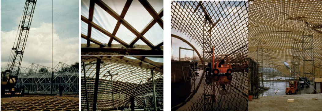
Şekil 8. Yukarıya çekme yöntemi; Essen Pavilion (Alman Yapı Sergisi DEUBAU) (Chilton ve Tang, 2016, s. 18), Yukarıya itme yöntemi; Multihalle Mannheim forkliftlerle itilen ızgara ve H şeklinde kuvvet yayıcı kirişler (Chilton ve Tang, 2016, s. 34).
