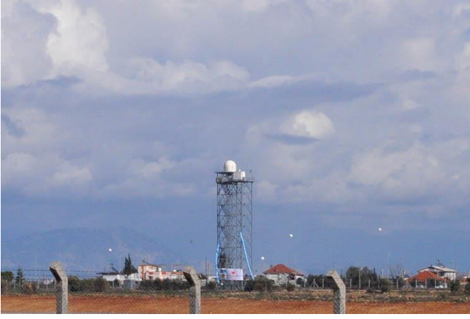
Şekil 1. Antalya Havalimanında İşletime Açılan Alçak Seviye Rüzgar Kesme Uyarı Sistemi (LLWAS)
