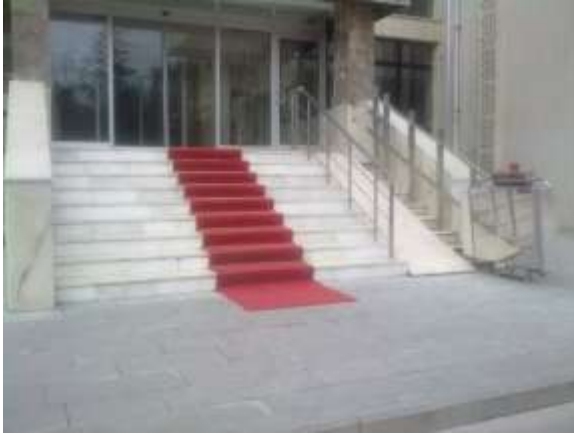
Şekil 27. Güvenlik ve konforlu olmayan rampa örneği (Orijinal 2016).
