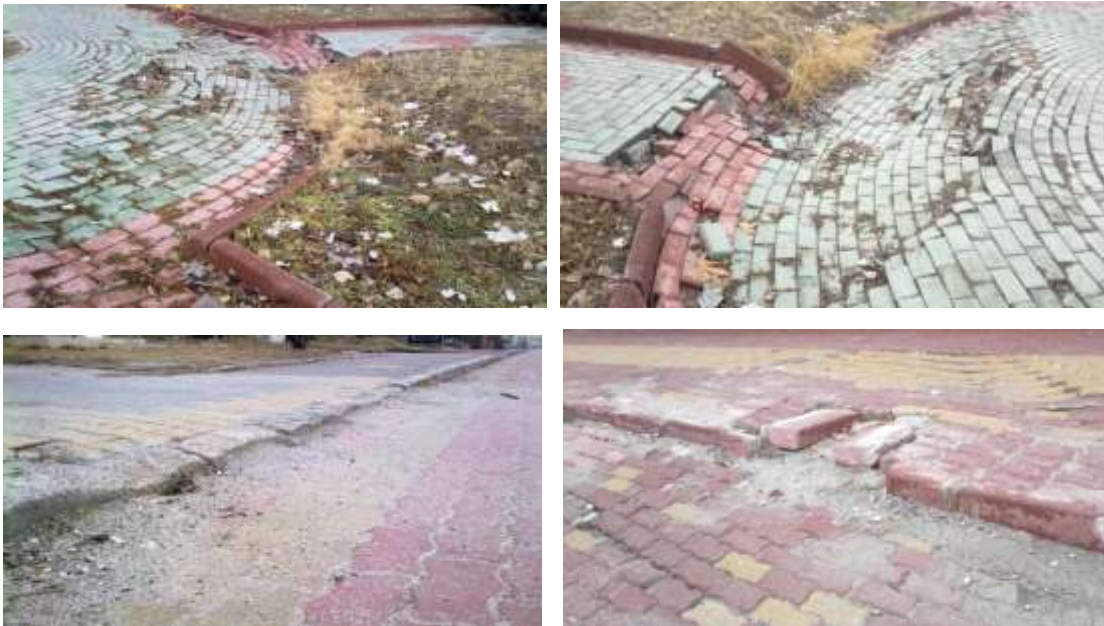
Şekil 15. Yaya kaldırımında güvenliğe ilişkin sorun teşkil eden bozulmalar (Orijinal 2016).
