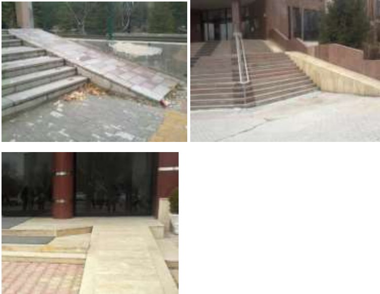
Şekil 24. Rampalarda eğim (Orijinal 2016).
