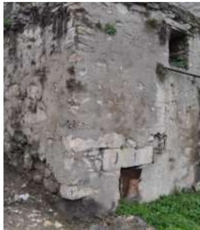
Resim 9. Tarihi Gezi Hamamının Kuzeydoğusundaki Depo Duvarı, Devşirme Malzemeler
