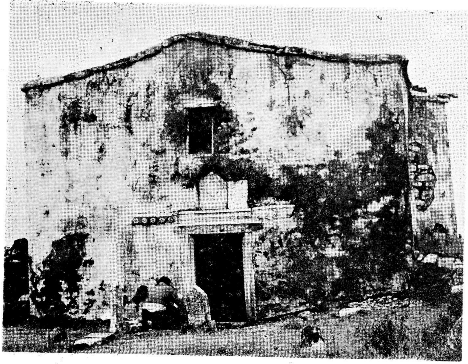
Res. 6- Sarı Lala Türbesi (Ortaköy/Çifteler). Doğu cephesi.
