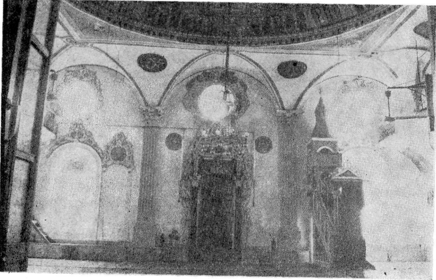
Res. 8- Kırkağaç Çiftahanlar Camii, Mihrap Duvarı
