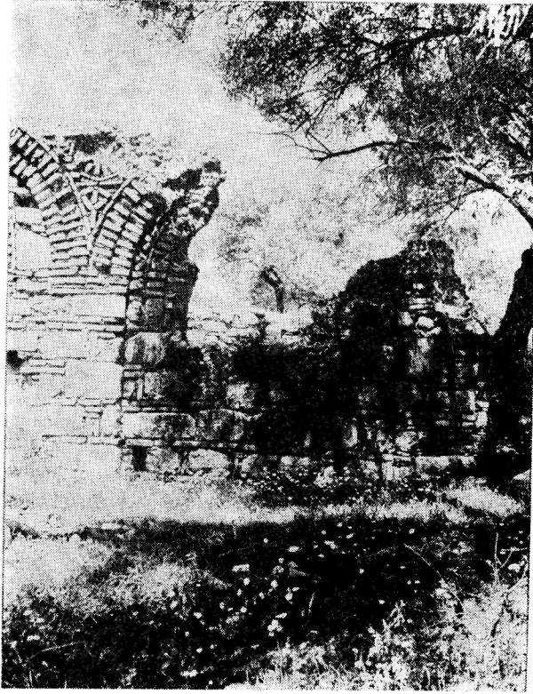
Res. 7- Kirselik'teki manastır kilisesi, eksonarteksin güney cephesi, ayrıntı, pencere açıklığı
