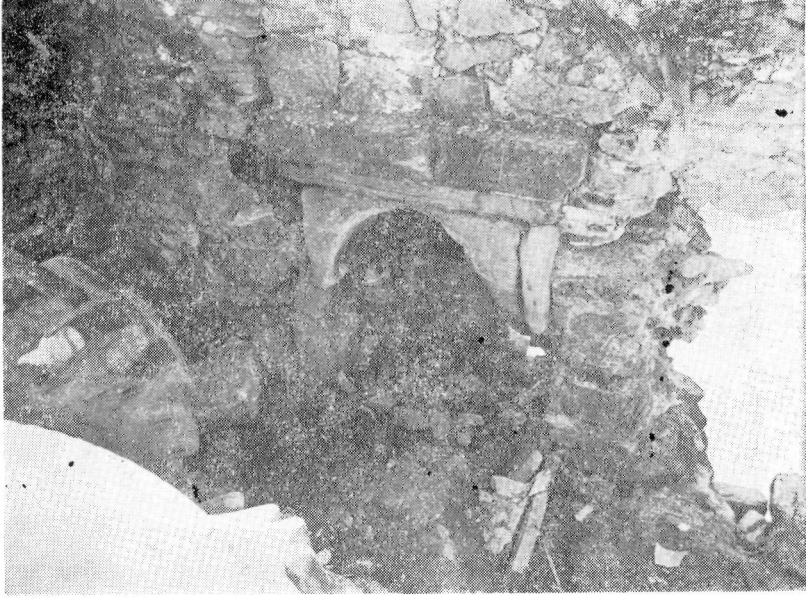
Res. 7- Gökçeagaç Hanı (Sinop-Kastamonu). Giriş mekanındaki mihrap.
