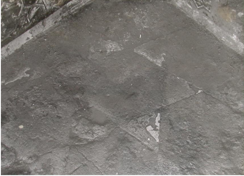
Res.26- Kuzeydoğu odanın zemin döşeme çinileri. (V.G.M.Arşivi)
