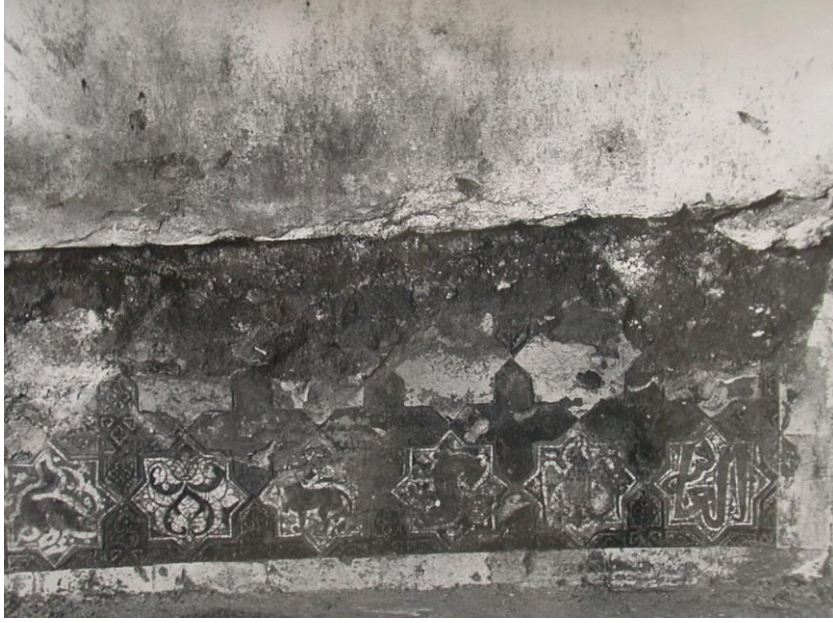
Res.23- Kuzeydođu oda, kuzeydođu cephedeki çiniler. (V.G.M.Arşivi)
