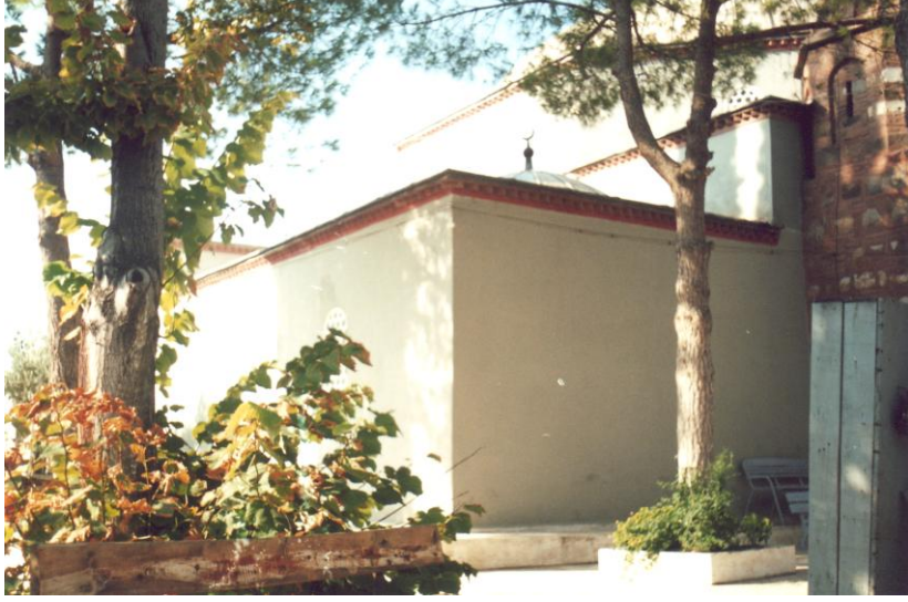
Res. 1- Akhisar Ulu Cami. Doğu cephesi.
