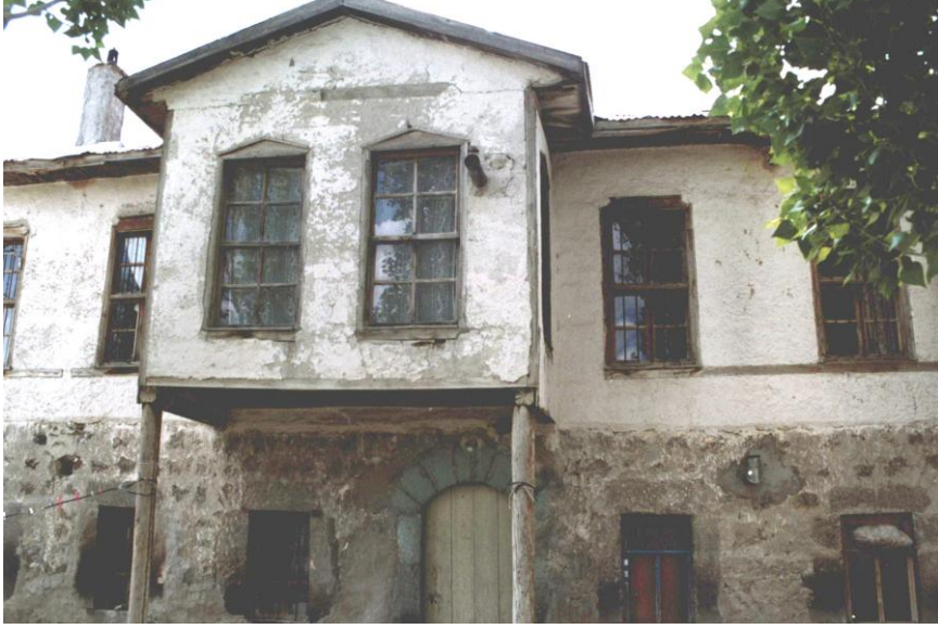
Res. 21- Mehmet Aydoğan Evi Giriş Cephesi
