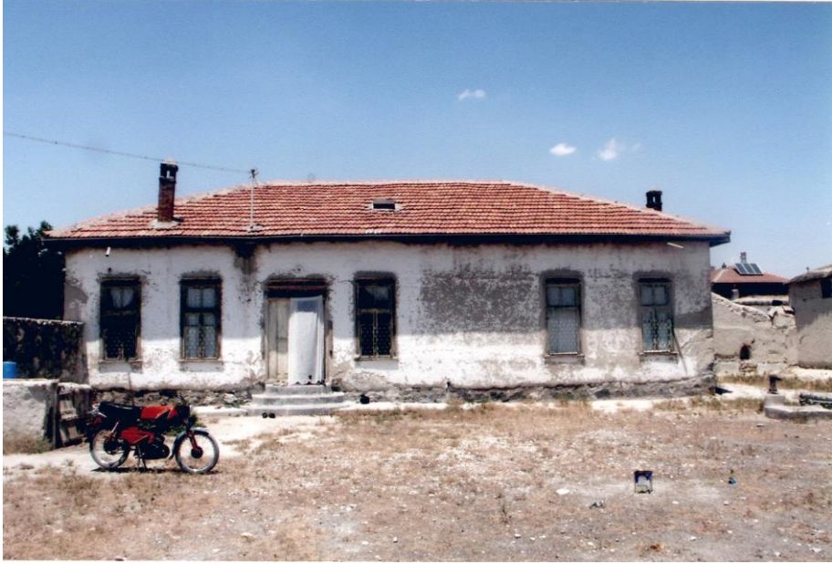
Res. 17- Bekir Sayar Evi Giriş Cephesi
