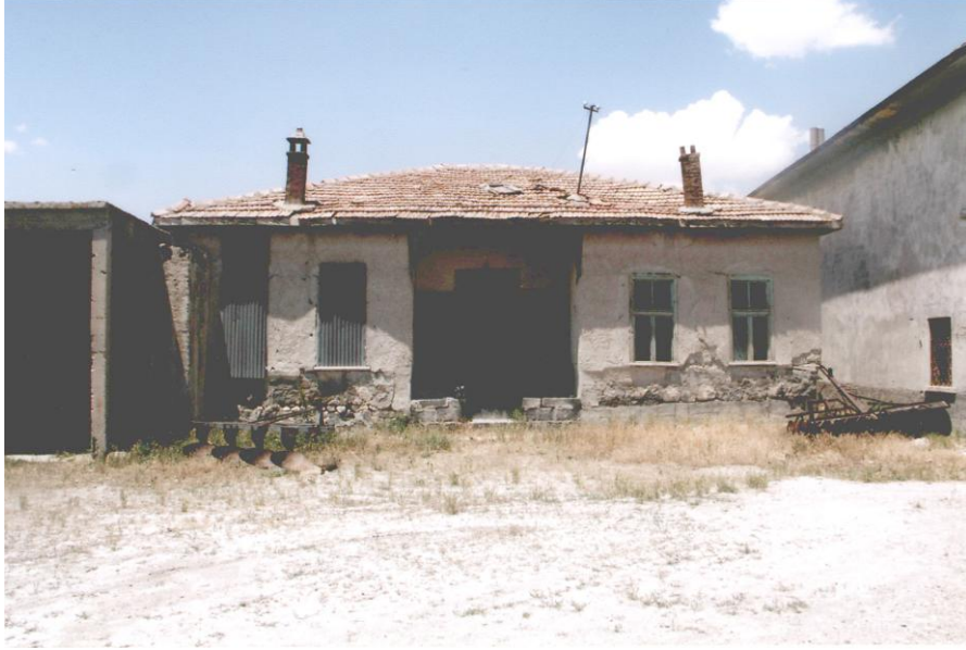
Res. 11- Hacı Ömer Yeşilyurt Evi Giriş Cephesi
