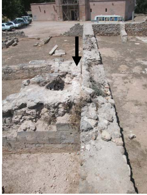
Res. 3- Orhan Camii'nin batı duvarına yaslanan Halka'nın doğu duvarı ve sonradan inşa edilen minare kürsüsü.
