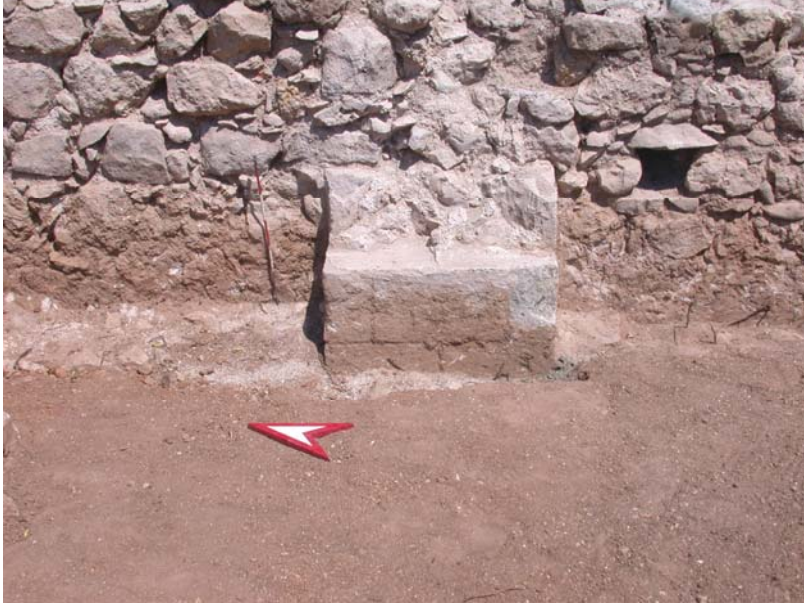
Res. 7- Seymenlik Zaviyesi. Mescid'in batı duvarı üzerindeki payanda.
