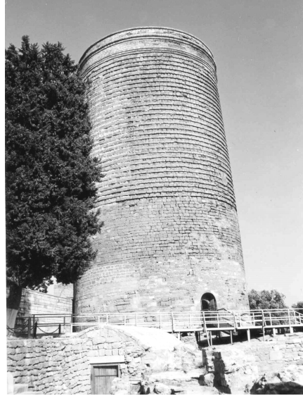
Res.2- Bakü Kız Kalesi, kuzeyden görünüşü
