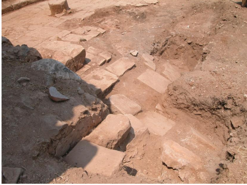
Res.5- Seymenlik Hamamı. Soyunmalık mekanının güneyinde çökmüş zemin döşemesi ve aralık mekanı girişi önündeki merdiven.
