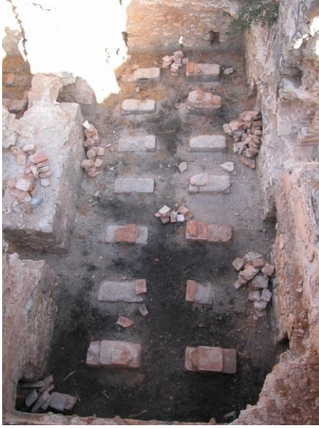
Res.32- Seymenlik Hamamı sıcaklık cehennemliğinde destekler. Konservasyon öncesi.
