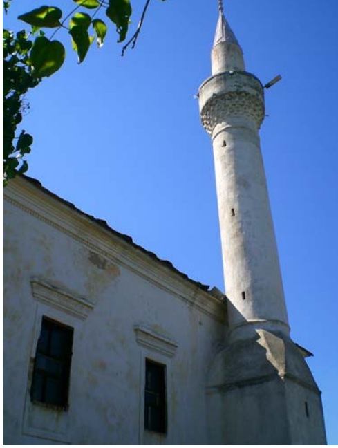
Res. 15- Ömerler Ali Rıza Bey Camii, doğu cephesi
