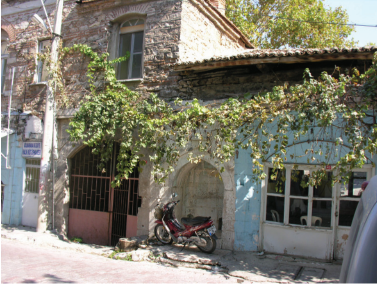
Resim 4- Gölarmara Halime Hatun İmaretı. Gırış eyvanı ve çeşme.
