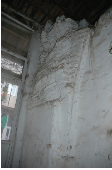
Resim 7- Gölarmara Halime Hatun İmaretı. IV. no.lu dükkanındaki kemer ızı.
