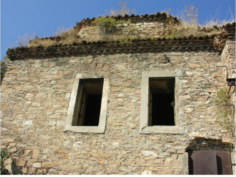
Resim 11- Gölmarmara Halime Hatun İmareti. Güney cephesinden ayrıntı.
