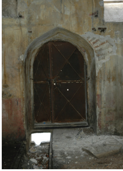
Resim 15- Gölarmara Halime Hatun İmaretı. VIII no.lu mekanda gırıŐe dñnüşürülen niŐ.
