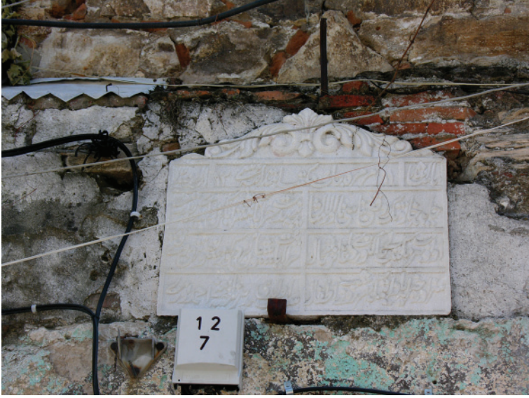
Resim 3- Gölarmara Halime Hatun İmaretı. Onarım kitabesı.
