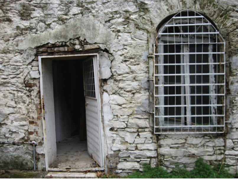
Resim 20- Gölmarmara Halime Hatun İmaretı. Hanın kuzey cephesinde giriş ve pencere.
