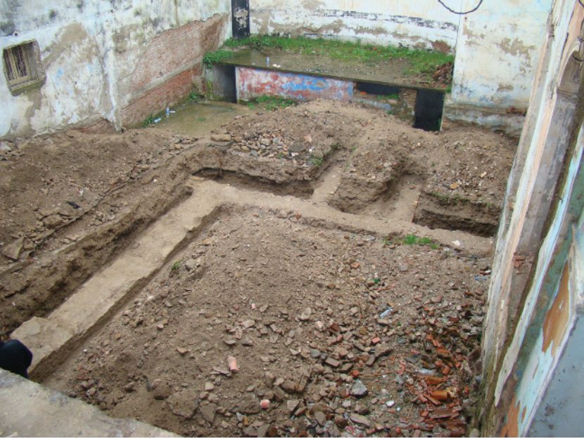
Resim 2- Kazı sonrasında ortaya çıkan naosun batı ve güney duvarına bakış.
