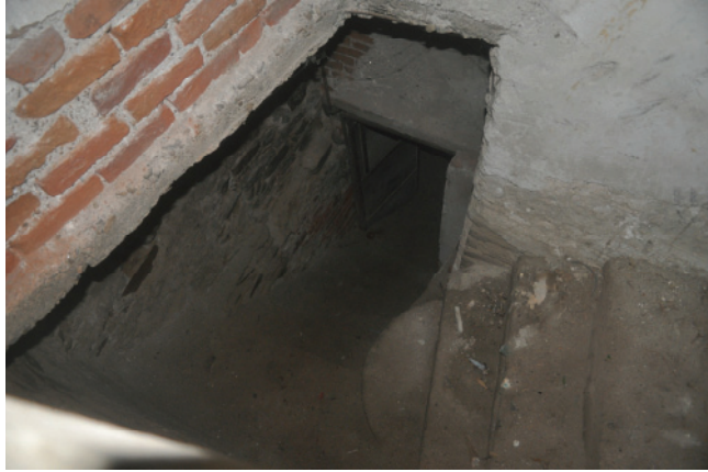
Resim 8- Kuzey duvarın doğusunda yer alan ve orijinalde bemaya açıldığı anlaşılan kapı. Daha sonradan kapının kemerinin önü tuğla ve beton malzeme ile kapatılmıştır. Ancak içten bakıldığında, kapının orijinalde yuvarlak kemerli bir giriş olduğu tespit edilebilmektedir.
