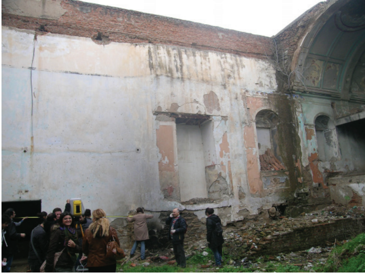
Resim 9- Kazı öncesinde, naosun kuzeybatı köşesine bakış.
