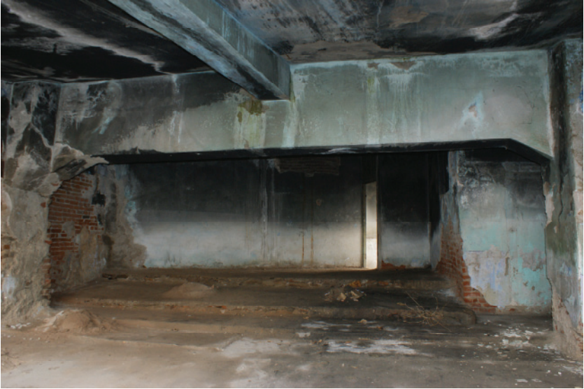
Resim 6- Kazı öncesi naosun doğusuna bakış. Naos içindeki eğimli beton tabliyeler mekanın algılanmasını engellemektedir..
