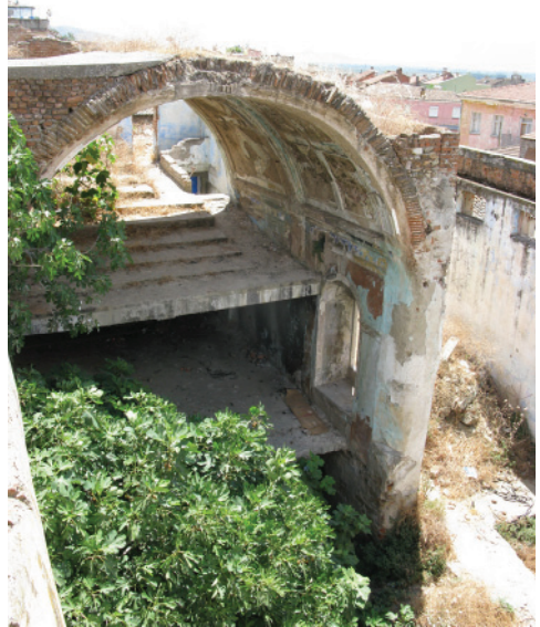
Resim 4- Naos içine inşa edilen beton tabliyelere kuzeybatı yönden bakış.
