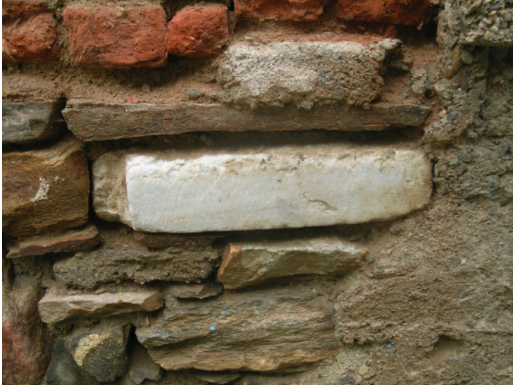
Resim 10- Sonradan yapıya eklenen duvarda devşirme malzeme olarak kullanılmış paye ayağı.
