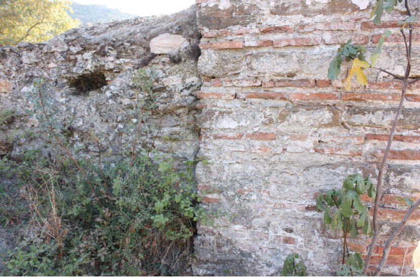
Resim 10: Sobicu Çerkez Köyü Çeşmesi Depo Kısımı ve Çeşme Duvarı
