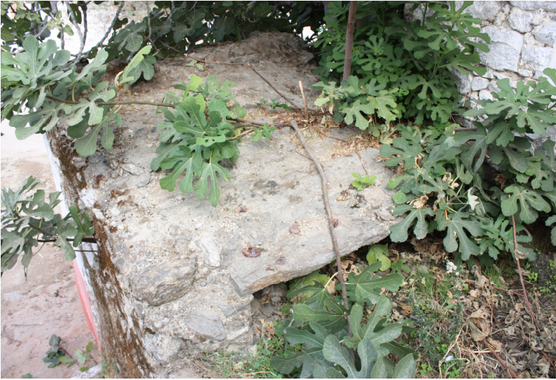
Resim 20: Güdüşlü Köyü Anonim Çeşme Depo Kısım Üst Örtü
