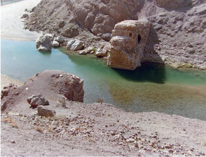
Res.2- Köprü ayaklarının kuzeydoğudan görünüşü.
