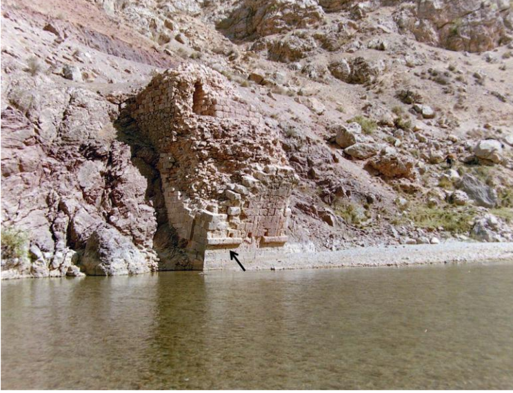
Res.5- Köprü doğu ayağının kuzeybatıdan görünüşü.
