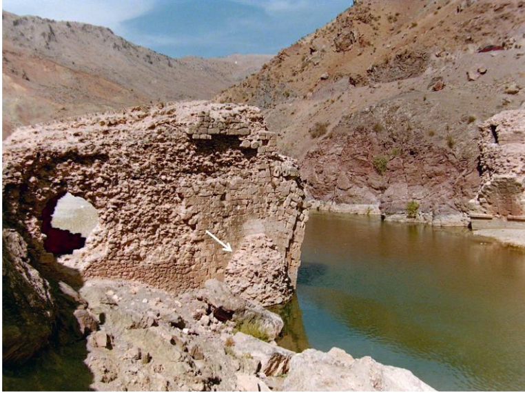
Res.10- Köprü ayaklarının güneybatıdan görünüşü. Batı ayağının güney yüzü üzerindeki payanda okla işaretli.
