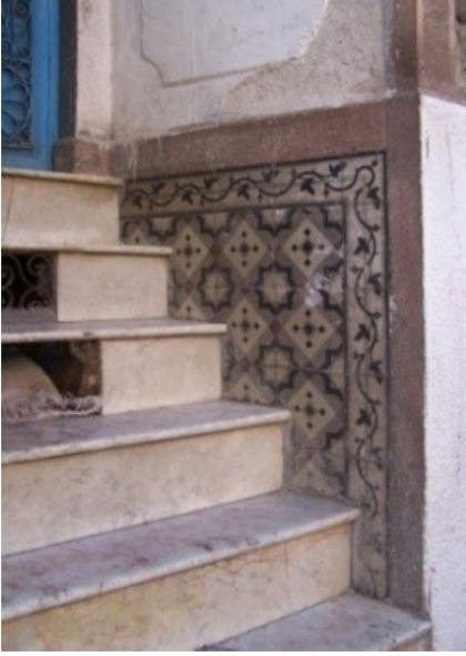
Res.16- Giriş eyvanı iki yan duvarında yer alan karosiman örneği.
