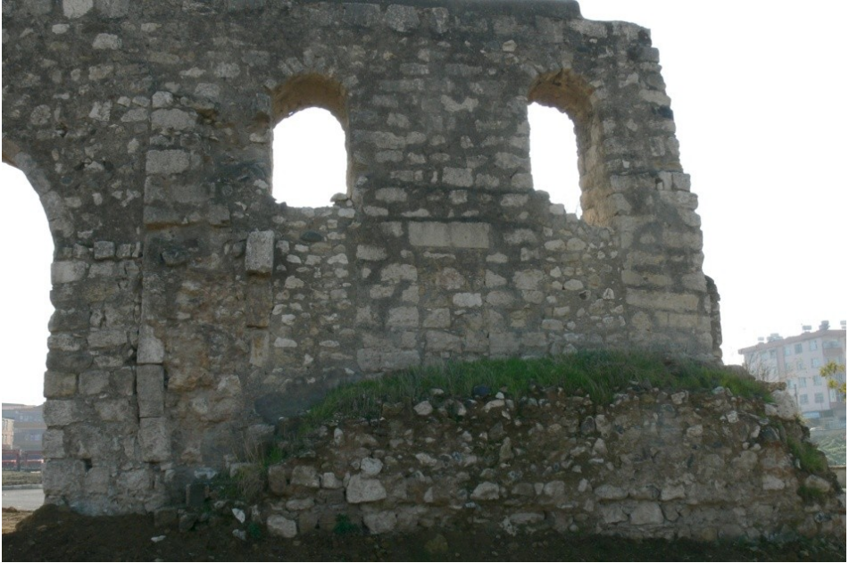
Res.11- 'Alvân Su Kemerî; Başlangıç Bölümü . (Kuzey cephe)
