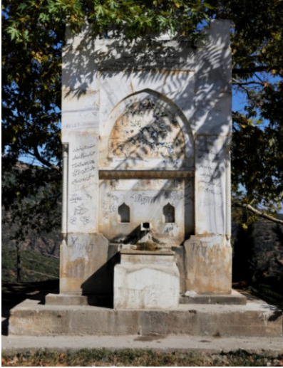
Res.2- Paşa cephesi, ön cephe.
