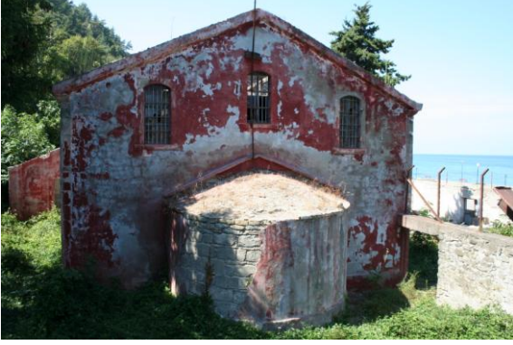
Res.8- Doğu cephe.
