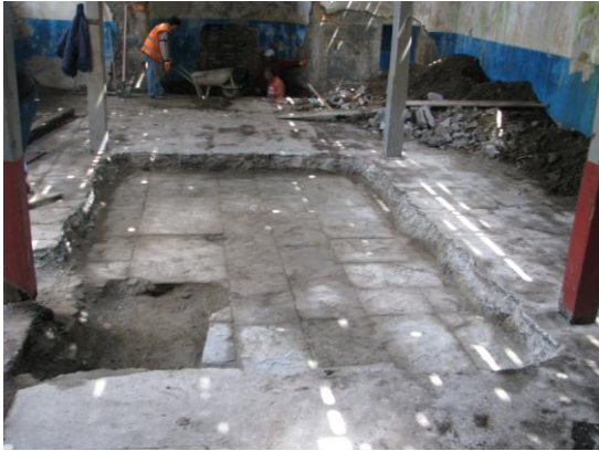
Res.5- Naosun orijinal zemin kaplaması.
