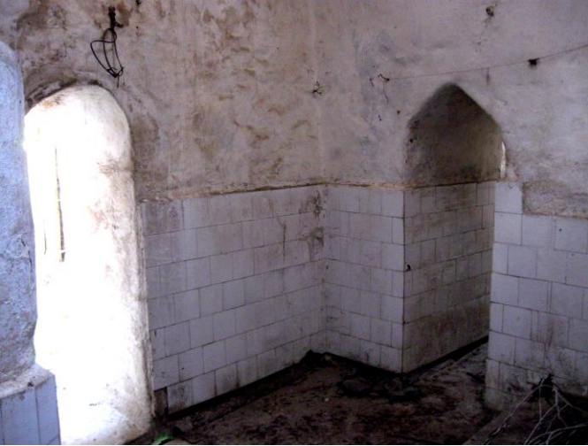
Res.10- Ilıklik mekanı, sağda sıcaklık kapısı
