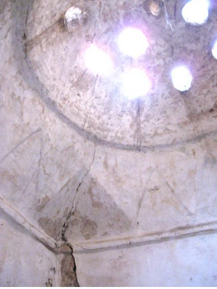
Res.9- Ilıklik mekanında geçiş ve örtü sistemi
